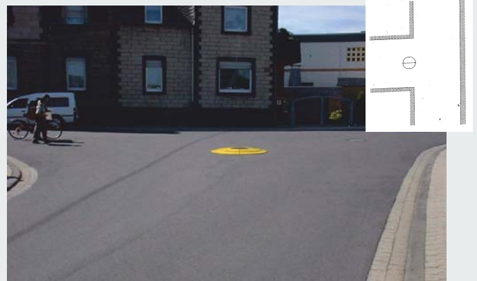
Beruhigungsinsel an einer Straßeneinmündung Soft speed reducer on a street junction
