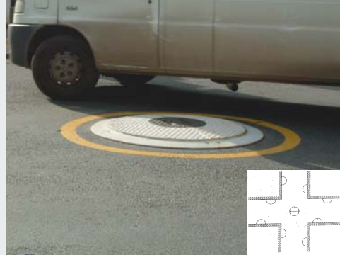
Mini-Kreisverkehr Small roundabout
