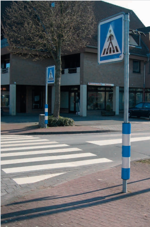
Leitzylinder für erhöhte Aufmerksamkeit
