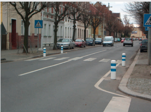
Balisette alternativ oder zusätzlich zum Leitzylinder an Fußgängerüberwege
