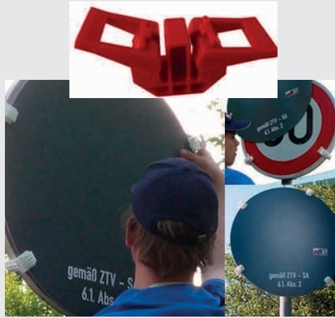
Duplexklemme zum kurzfristigen Abdecken von Verkehrsschildern o.ä.
