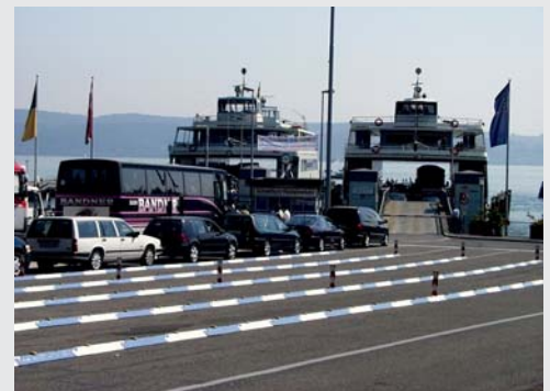
Wartespur-Trennung an einer Fähre Separation of queue-up lanes at a ferry
