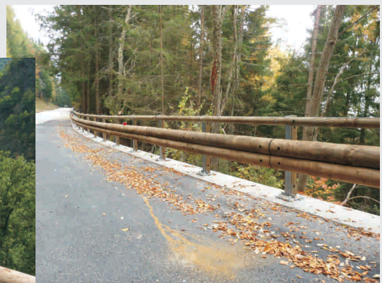
Schwere Ausführung Doppelbeplankung mit Handlauf
