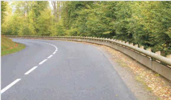
Standardausführung mit Unterfahrschutz
