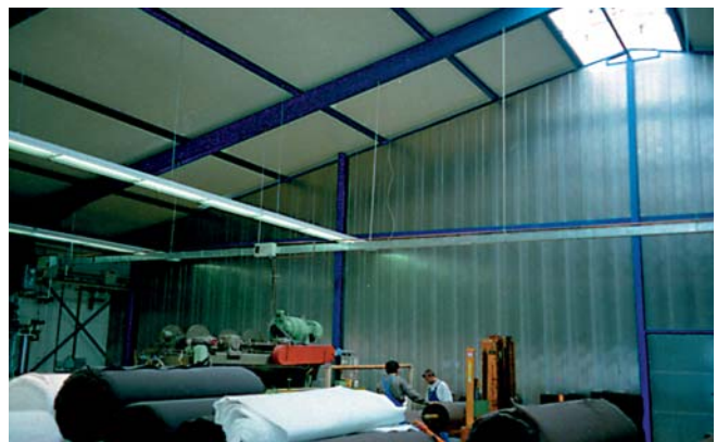
Lärmschutzwand in Fertigungshalle
