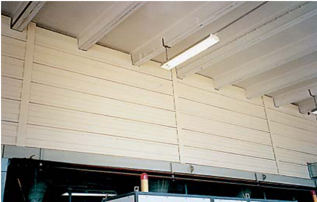
Lärmschutzwand auf Granulatbühne
