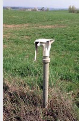
Schäden durch Winterdienst damages through snow clearing
