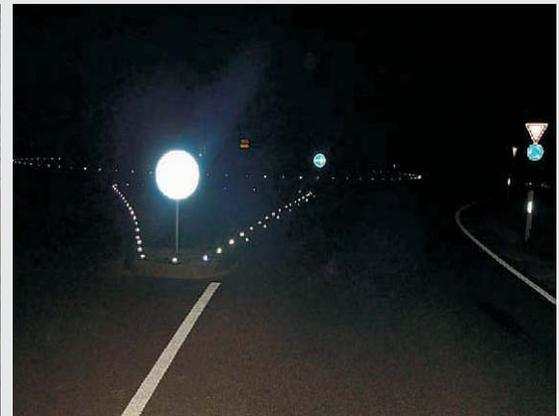
Glasmarkierungsknöpfe - mehr Sicherheit durch sichtbare Verkehrsführungen
