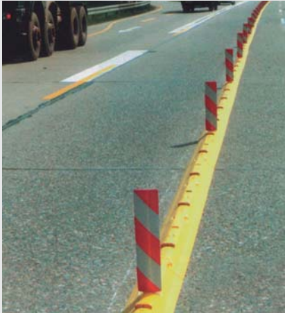
Fahrbahntrennung bei einer Autobahnbaustelle Lane marking in motorway roadworks
