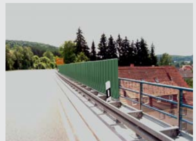
Blend- und Spritzschutz Anti-glare and splash protection
