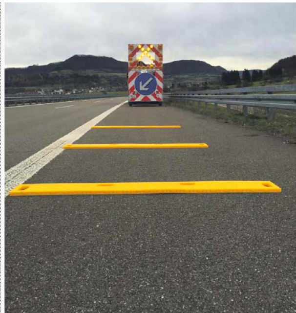
Die Warnschwelle besitzt neben dem hochbelastbaren und witterungsbeständigen Material Reflektoren zur besseren Nachtsicht.
