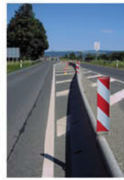
Leitfahne mit Stahlhalterung für Mini-Guard
