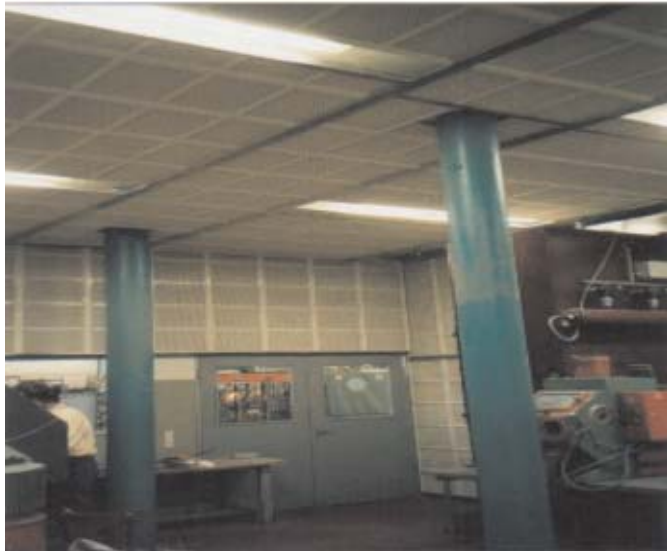
Lärmschutzwand in Fertigungshalle
